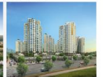
(주)우방건설산업 경북도청신도시3차 우방아이유셀센트럴
